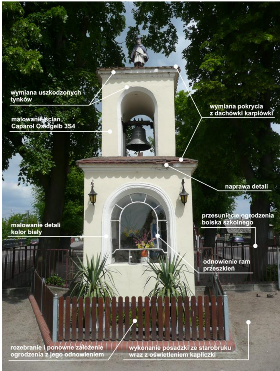
Prace remontowe przy istniejącej kapliczce
