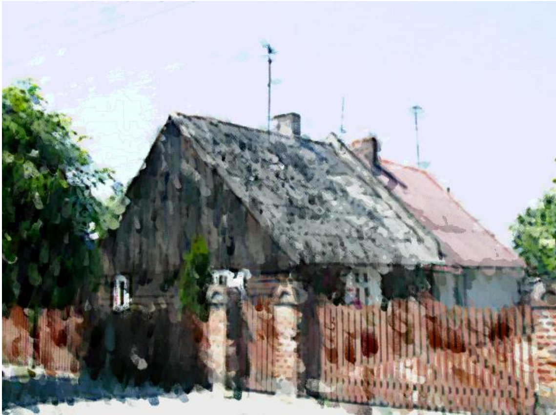
Budynek mieszkalny konstrukcji drewnianej z połowy XIX w., charakterystyczne słupy ceglane
