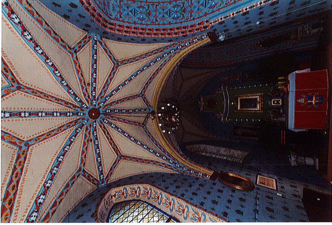
Fot. 12 Wnętrze kościoła p.w. Najświętszej Maryi Panny Wniebowziętej, św. Jana Chrzyciela i św. Jana Ewangelisty w Lwówku. Widok kaplicy Matki Bożej. Widoczny stan zachowania malowideł na powierzchni ścian i sklepień.
