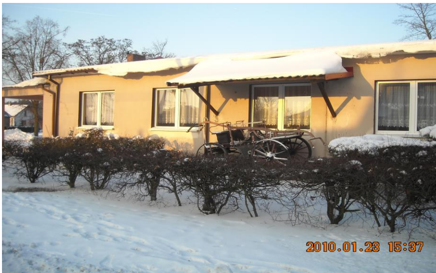
Świetlica wiejska wybudowana w 1968 roku.
