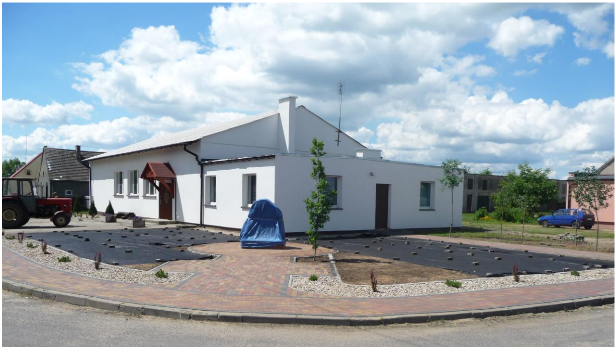
Budynek świetlicy wiejskiej w centrum wioski.
